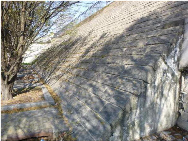
Base du mur de quai (mur de quai)
